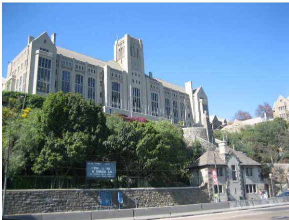
Hauptgebäude der UTFSM
